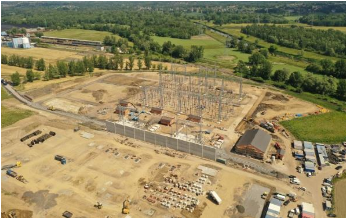
Obr. Výstavba nové transformovny v lokalitě Dětmárovice, Česká republika
